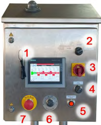
Abbildung 13: Bedienelemente am Bedienfeld
