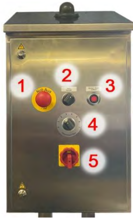
Abbildung 19: Bedienelemente am Bedienfeld
