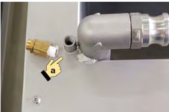
Abbildung 67: Anschlussstelle Sicherheitsventil
